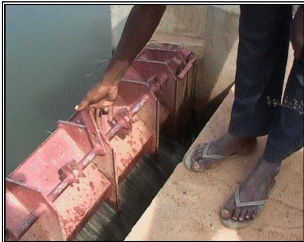
La vanne de la prise d'arroiseur, dont l'aiguadier détenait la clef, a été arrachée. Selon le chef d'arroiseur, les exploitants possédant des buttes ne jugeaient pas suffisant le temps d'ouverture défini par l'aiguadier. Les exploitants de bas-fonds, inondés par le « gonflage » du canal nécessaire à l'irrigation des buttes, bouchent à leur tour la prise avec ce qu'ils peuvent.
