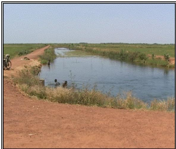
Le réseau a été partiellement réhabilité entre 2000 et 2002 sur la base d'un financement AFD. Les prises de partiteur sont équipées de vannes plates. Les prises d'arroseur sont équipées de modules à masque. Les cavaliers de partiteur sont latérités, mais pas ceux des arroseurs. Les travaux des parcelles et des rigoles ont été réalisés par les paysans eux-mêmes, qui confient avoir dû recréuser également certaines parties des arroseurs.
