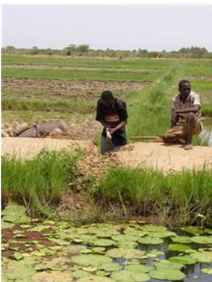
Photo 2: Exploitant se construisant sa propre prise de rigole
