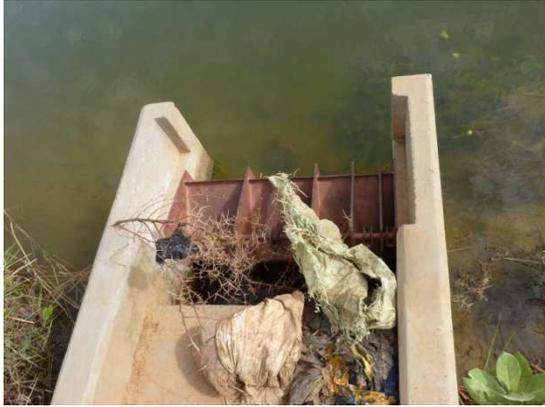
Photo 3: Module à masque bouché avec du tissu et des branchages
