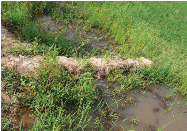
Illustration 5: Diguettes érigées dans le réseau de drainage tertiaire pour éviter le reflux (théoriquement amont en haut et aval en bas)
