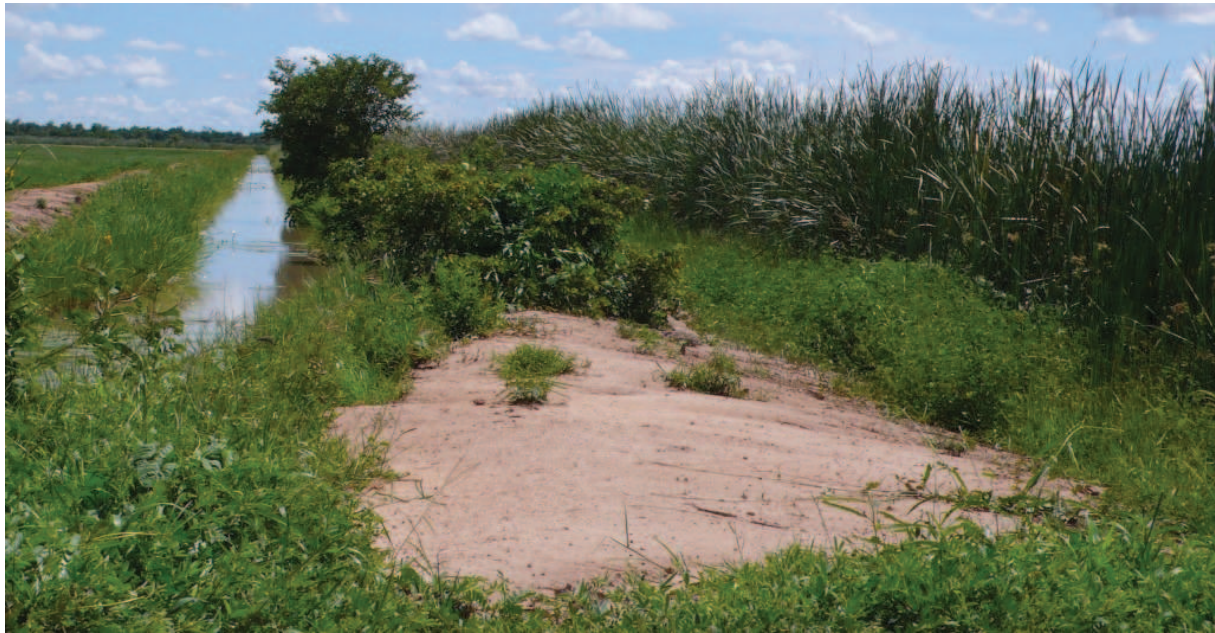
Illustration 7: Disparité dans l'entretien du réseau tertiaire: arroseur (à gauche) et drain (à droite)
