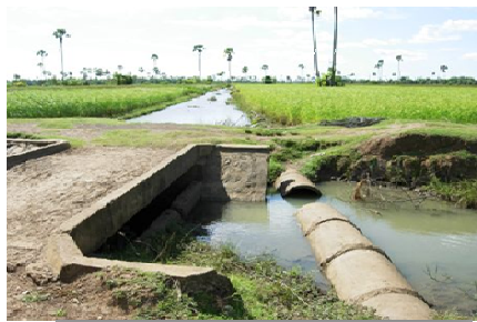
Déversoir du canal B avant entretien
