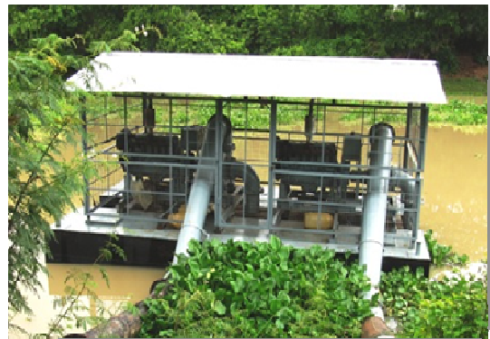
Station de pompage de Sdao Kong après entretien
