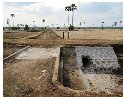
Déversoir du canal B après entretien
